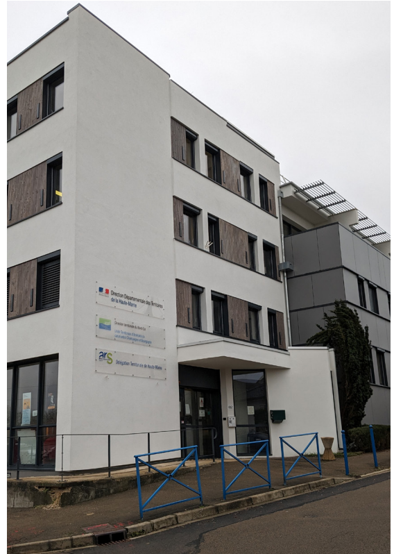
Façade DDT après travaux
