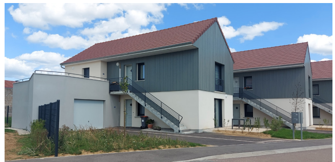
Contrôle de 14 logements Hamaris sur la commune de Chalindrey
